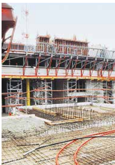
Mise en œuvre en fond de coffrage
