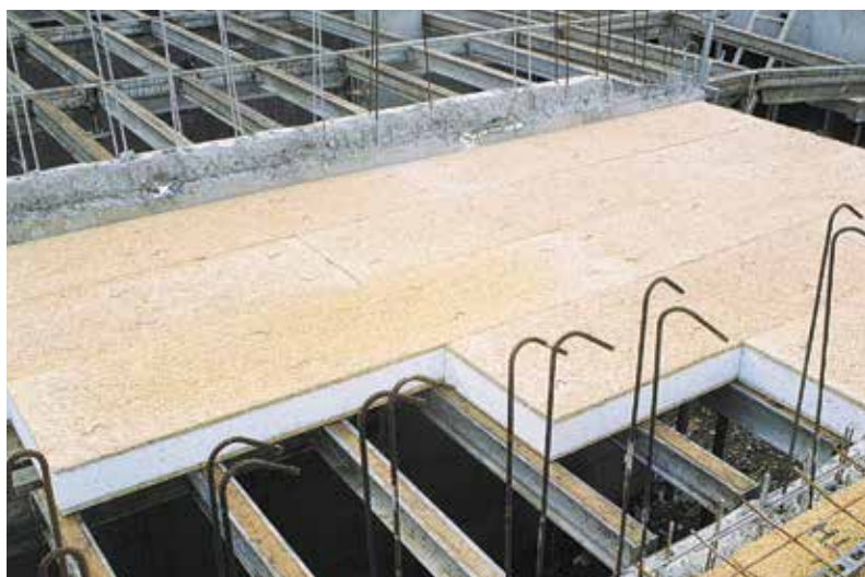
Pose de panneaux agrafés sur coffrage industrialisé
