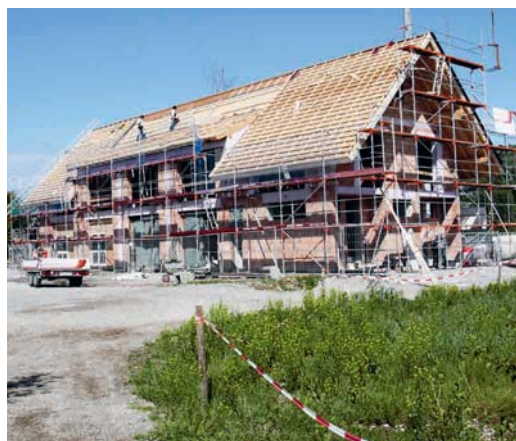
Une isolation sur chevrons en continu facile à mettre en œuvre.
