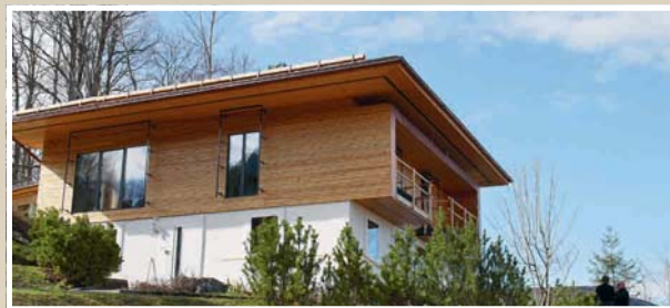
Cette maison, située à Bad Dürrenberg en Autriche, a été rénovée et dotée d'une façade en bois. Des panneaux isolants PAVATEX en fibres de bois ont été utilisés pour isoler le bâtiment de manière efficace sur le plan énergétique.
