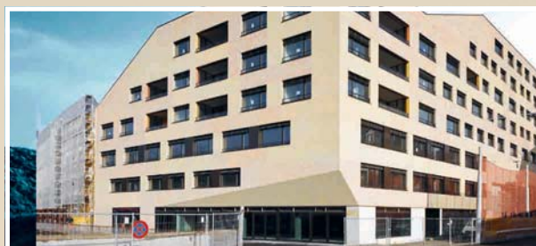
Le bâtiment d'habitation et commercial Kalkbreite à Zurich est considéré comme un modèle de construction économique et écologique. L'isolation extérieure a été réalisée grâce aux panneaux isolants en fibres de bois DIFFUTHERM.
