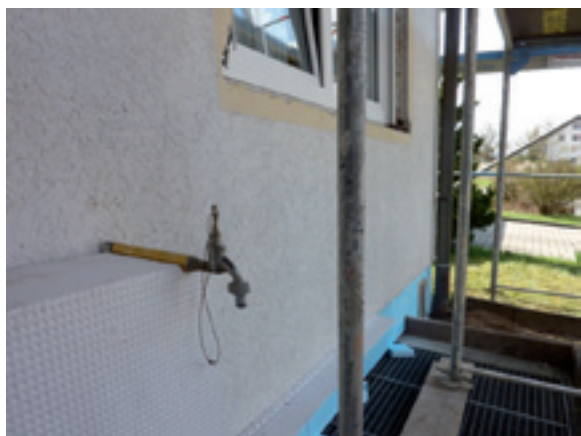
Rallonger le robinet en fonction de l'épaisseur de l'isolant.
