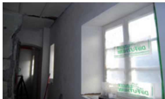
Pour que le raccord à l'enduit soit net, coller le profilé de jonction auto-adhésif UdiTRAME ® INSIDE sur le châssis et couvrir d'enduit UdiENDUIT DE FOND ® pour l'intérieur.
