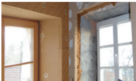
Pour terminer, équiper les retours de tableaux (fenêtres et portes) de panneaux isolants prévus pour les embrasures et les tableaux.
