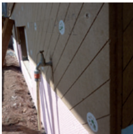
Les éléments isolants installés, le robinet est à nouveau opérationnel.
