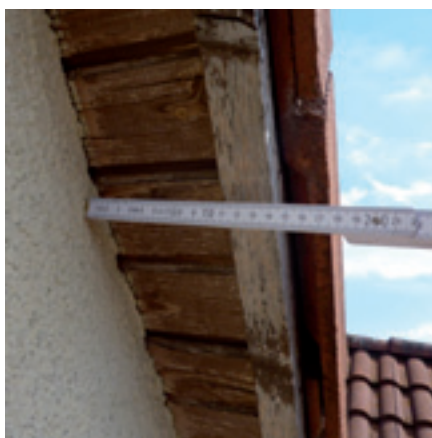
Contrôler le débord du toit qui va diminuer en fonction de l'épaisseur de l'isolant.
