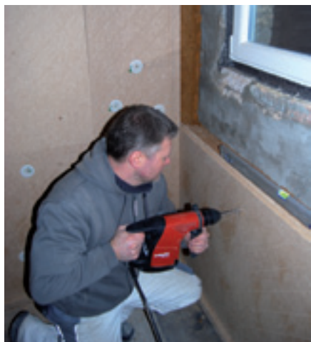
Poser au moins 8 chevilles de réglage par élément isolant UdiRECO ® en fibre de bois.
