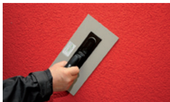
La structure finale sera créée manuellement ou à la machine en utilisant des projecteurs permettant de doser le produit. L'aspect final de la structure doit être homogène, elle peut cependant présenter quelques variations en fonction du travail de l'artisan.
