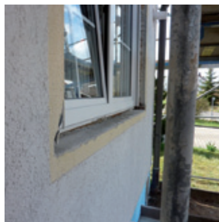
Avant les travaux, mesurer avec précision la longueur du rebord de fenêtre.
