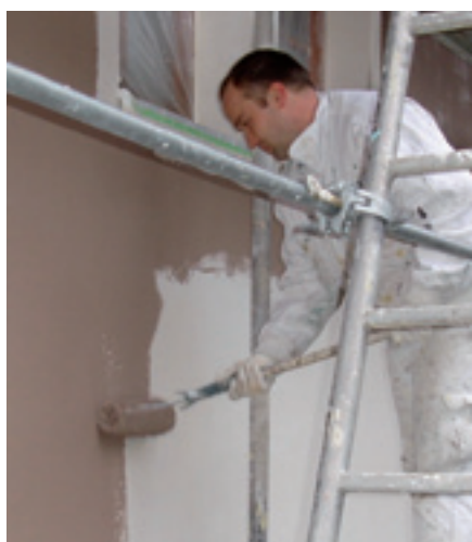
Appliquer la peinture primaire à l'aide d'un rouleau en respectant la nuance de couleur et le système,
