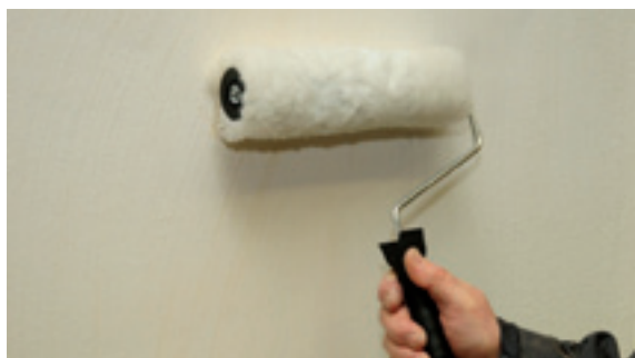
Appliquer la peinture primaire à l'aide d'un rouleau en respectant la nuance de couleur et le système,
