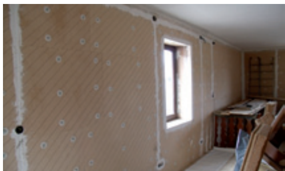
Il est possible de fraiser des passages verticaux ou horizontaux dans l'isolant pour incorporer les gaines électriques. Une autre solution est de passer les gaines des câbles dans la couche semi-rigide du panneau.
