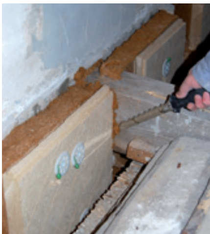
Boucher les jonctions avec les chutes des matériaux isolants.
