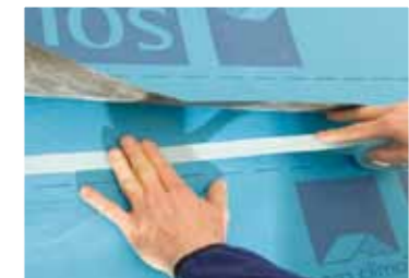
TESCON No.1 / TESCON VANA Pour le collage des chevauchements de lés
