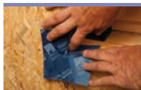
Collage sur les angles de menuiseries
