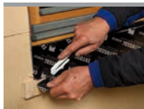
Couper horizontalement les extrémités
