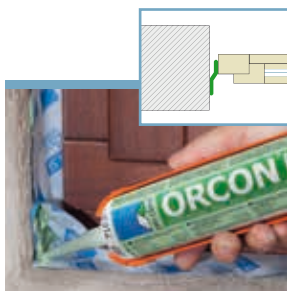
Construction massive, CONTEGA SL a déjà été raccordé sur le côté du châssis
