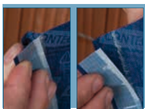
La boucle de dilatation compense les mouvements des éléments de construction
