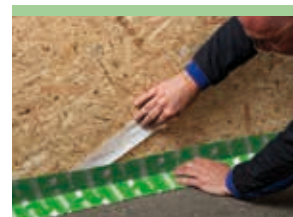
Coller sur cloison
