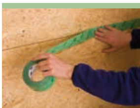
Préparation / collage des joints de panneaux
