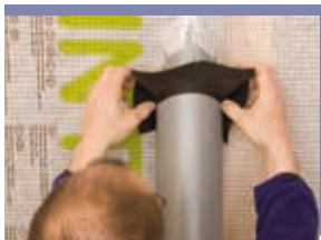
Passer la manchette par-dessus le conduit et la positionner
