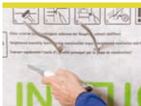
Marquer l'emplacement sur le support et le découper
