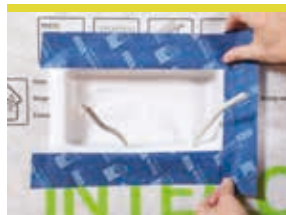
Coller sur le support de manière étanche à l'air
