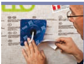
Retirer le film de protection
