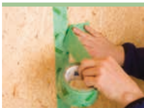
Consolidation des joints verticaux
