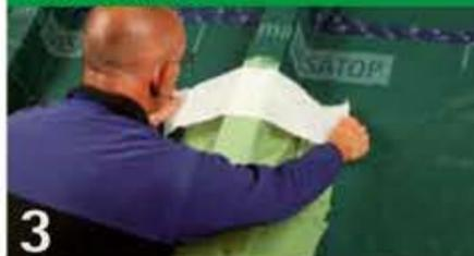
Insérer le non-tissé dans le matériau d'étanchéité. Si nécessaire, enduire les bords du non-tissé avec plus de matériau d'étanchéité. Pour de grandes surfaces, poser progressivement des pièces de non-tissé se chevauchant. Recouvrir les chevauchements avec du matériau d'étanchéité.
