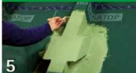
Raccord complètement étanchéifié. Sec après environ 2h30 à 3h30 de temps (à 20°C et à 60% d'humidité relative de l'air).
