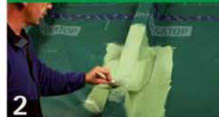
Enduire le support avec le matériau d'étanchéité. Ne pas choisir de surfaces trop petites afin que par la suite, le non-tissé puisse être recouvert complètement.
