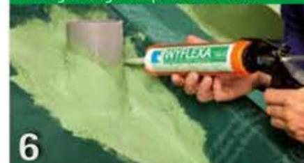
Appliquer avec la cartouche le matériau d'étanchéité aux endroits difficiles d'accès. Idéalement, pour des petites surfaces ou des surfaces compliquées, WYFLEXA est utilisé à partir de la cartouche.
