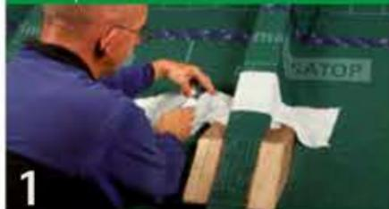
Découper le non-tissé à la longueur souhaitée. Placer pour essai les surfaces à étancher. En cas de surfaces compliquées, utiliser plusieurs morceaux de non-tissé.
