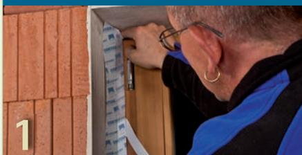
Commencez le collage dans le coin. Posez d'abord le ruban sur une longueur d'env. 2 cm sur la partie horizontale du dormant, puis collez-le au châssis. Faites passer le ruban dans le coin et collez-le à la partie verticale du châssis. Lors du collage, détachez le film transfert au fur et à mesure.
