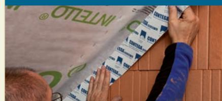
Amenez le frein-vapeur en place. Réalisez le pli de dilatation afin de permettre une compensation des mouvements de l'ouvrage. Détachez toutes les bandes de film transfert du ruban CONTEGA SOLIDO SL. Posez le ruban et collez-le au fur et à mesure ; pour qu'il adhère bien, maroufflez-le à l'aide de la spatule pro clima PRESSFIX.
