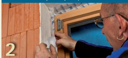
Détachez la bande de film transfert la plus large et collez le ruban au fur et à mesure sur le pourtour de l'embrasure. Pour que le ruban y adhère bien, maroufflez-le à l'aide de la spatule pro clima PRESSFIX.
