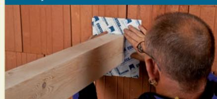
Découpez quatre morceaux de ruban. Détachez le film transfert le plus étroit et collez le ruban sur le premier flanc de la solive. Détachez le film transfert le plus large et collez le ruban sur le mur. Dans les coins de la solive, entaillez le ruban de manière à pouvoir le coller sur le côté adjacent de la solive. Réalisez de façon similaire le raccord étanche à l'air de tous les autres côtés.
