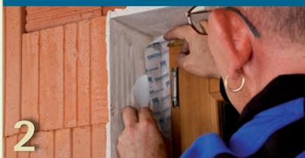
Détachez la seconde bande de film transfert (la plus large) au fur et à mesure. Commencez le collage sur l'embrasure dans un coin. Collez la partie qui dépasse sur le côté adjacent de l'embrasure. Collez le ruban jusque dans le coin suivant.
