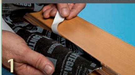
Détachez la bande de film transfert la plus étroite, posez le ruban à fleur sur le côté du dormant, puis collez-le au fur et à mesure. La face imprimée de la bande vers le haut.
