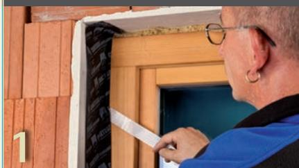
Détachez la bande de film transfert la plus étroite. Posez CONTEGA SOLIDO EXO directement sur le coin du dormant, en le laissant dépasser d'environ 2 cm. Collez la partie qui dépasse dans le côté adjacent de l'embrasure.
