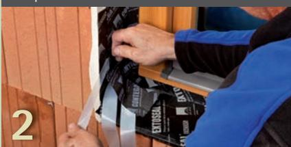
Détachez la bande de film transfert et collez le ruban au fur et à mesure sur l'embrasure. Réalisez le pli de dilatation afin de permettre une compensation des mouvements de l'ouvrage. Collez le ruban sur l'appui de fenêtre.
