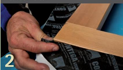
Pour permettre ultérieurement un collage facile et fiable du ruban dans l'embrasure de la fenêtre, réalisez les plis dans les coins comme illustré ici, puis collez CONTEGA SOLIDO EXO sur tout le pourtour.
