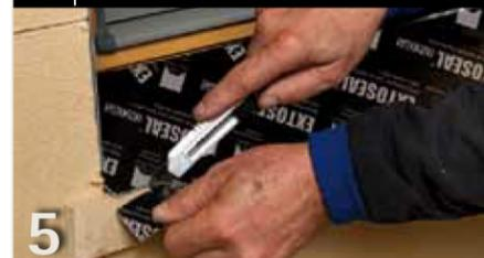
5 Recouper jusqu'à 15mm l'extrémité horizontale de la bande à l'aide d'un plan de travail afin que la bande puisse avoir prise plus tard sur le plâtre.
