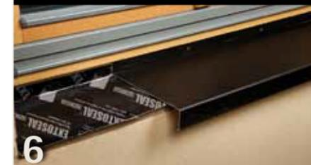
6 Rebord de fenêtre préparé avec EXTOSEAL ENCORS. Le plâtrier colle ensuite le profilé au morceau de bande qui dépasse. Protection définitive du tableau par la pose d'une bavette.
