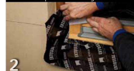
2 Replier la bande dans les coins d'env. 20 cm sur les ébrasements et coller également sur le dormant.
