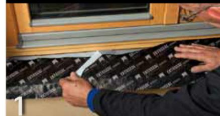
1 Couper et mesure la bande (largeur d'ouverture + 2x 20 cm). Décoller progressivement la partie mince du papier transfert et coller la bande au fur et à mesure au dormant dans le joint du rebord de fenêtre.
