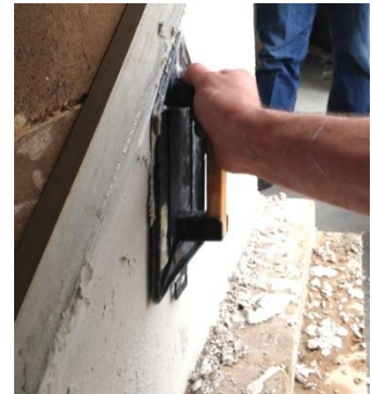
Application à la plâtresse en plastique
