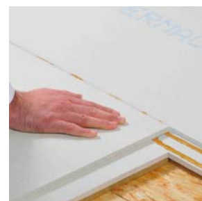
Collage des plaques avec des joints complètement remplis sur la battue
