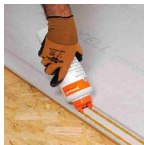
Application de la colle pour plaques de sol FERMACELL sur la battue
