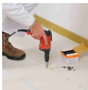
Fixation de la plaque à l'aide de vis...
