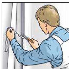
5. Découper le lé dans les coins et sur les bords, puis poser le lé suivant bord à bord à joints vifs.
