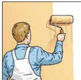
6. Après séchage, recouvrir d'une peinture émulsion de qualité supérieure suivant DIN EN 13300 ou par exemple d'un crépi, papier peint ou produit similaire.
