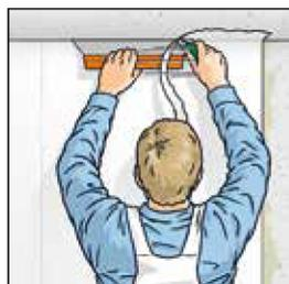
4. Enlever les excédents du plafond, des plinthes et fenêtres etc. à l'aide d'un cutter et d'une spatule.
