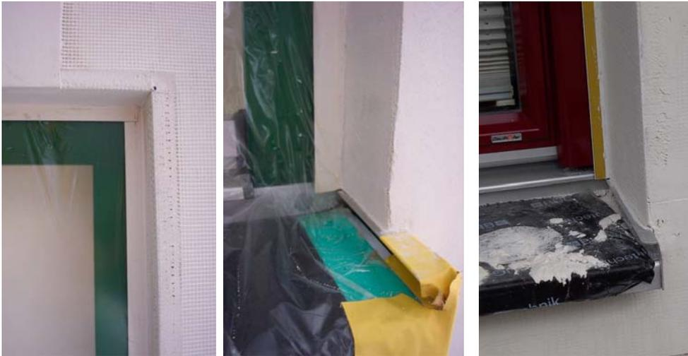
Appliquer au dessus et en dessous des angles des ouvertures de fenêtres et de portes les équerres textiles. Placer ensuite, mais uniquement au dessus des ouvertures, les pièces de toile armée tridimensionnelles à angle droit **UdiARMATURE®**. Lisser la couche de fond pour obtenir une surface plane (temps de séchage 1 mm = 1 jour). Utiliser une double couche de toile armée au niveau des arrêtes (par exemple au niveau de l'ancrage de l'échafaudage).
