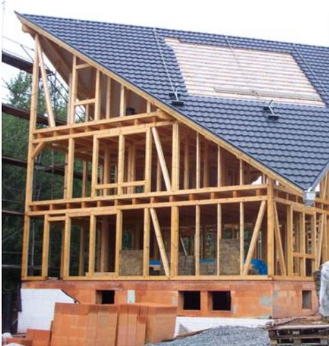
Sur le plan de la physique du bâtiment, ce type de construction correspond au niveau le plus avancé de la technique. Il permet d'exclure tous les vices de construction importants liés au point de rosée. Les propriétés perspirantes du système régularisent le transport d'humidité et contribuent ainsi à réduire les mouvements propres à la construction bois.
