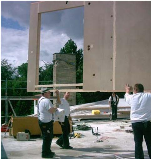
Pour la construction bois massive, les panneaux en fibre de bois Udi Unger-Diffutherm permettent de stabiliser l'humidité contenue dans le bois. Il en résulte un climat ambiant sain et extrêmement agréable. Il n'est plus nécessaire de poser un pare vapeur du côté intérieur.
