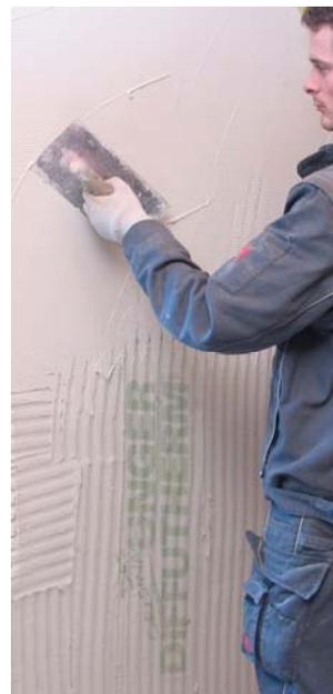
Recouvrir la partie inférieure de la toile avec la toile du profilé de casse-goutte. Procéder de même avec la toile de l'angle de rail de soubassement et la toile de la baguette de finition : les superposer sur 10 cm.
