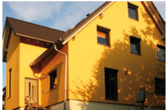
Façade après isolation et application de l'enduit
