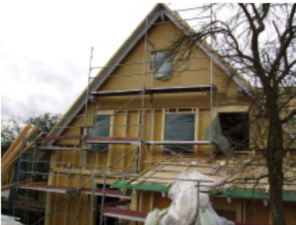
Nouvelle construction à ossature bois
