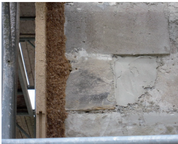
Le système Udi RECO® se raccorde au support sans laisser passer l'air
