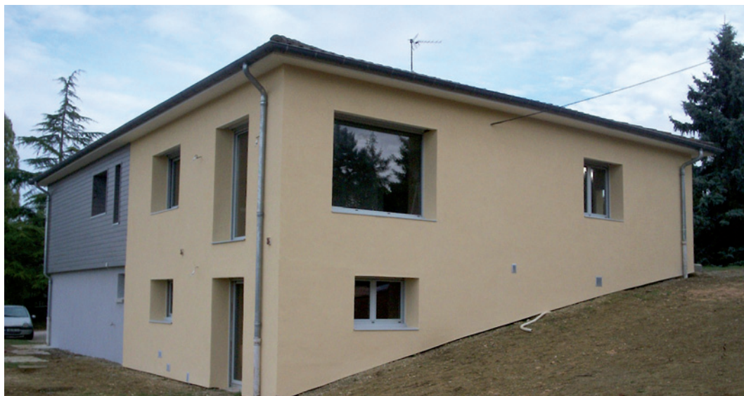
Maison à ossature bois, d'aspect méditerranéen, avec système Udi FRONT® 60 mm
