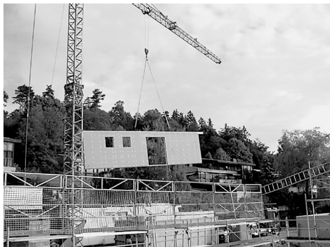
Montage d'éléments ossature bois préfabriqués
