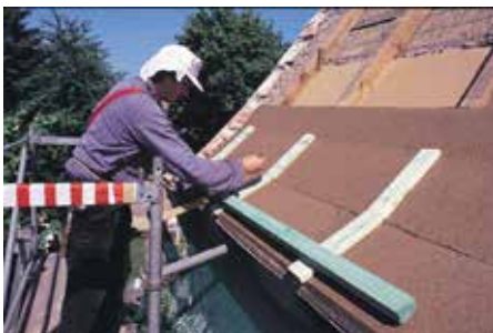
Photo à gauche: En cas de coyaux au pied de versant, il faut tenir compte de la brisure au niveau du raccord rainure-lanquette horizontal. A cet effet, la première rangée est découpée à la largeur correspondante (du bord avant du chevron jusqu'à la brisure).
